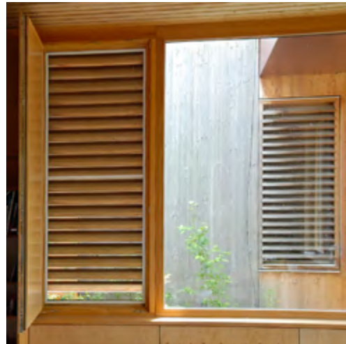
Nachtlüftungsöffnung Albert-Schweitzer-Schule, Foto: ABI, Abteilung Energiemanagement
